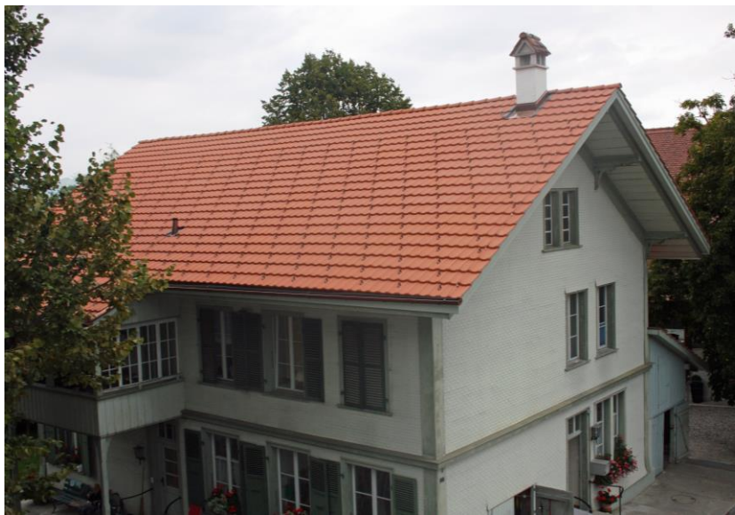
Saniertes Dach Dependance, Steffisburg, mit Berner Kaminhut
